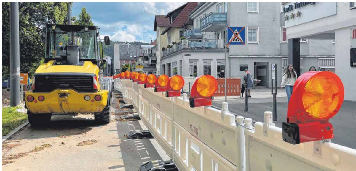
Bleibt so lange halbseitig gesperrt, wie die Baustelle Rathaussteg existiert: die Weimarstraße. ARCHIV-FOTO: DOROTHEA HECHT
