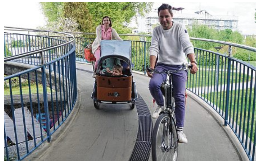
Die Spindel am Brückenkopf Nord der Neuen Rheinbrücke wurde vor dem Boom von Lastenrädern gebaut. Heute genügt sie nicht mehr den Anforderungen des Radverkehrs.
